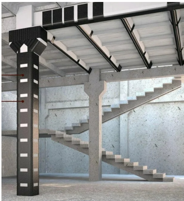
Рис. 1 - Усиление колонны композитными материалами.
