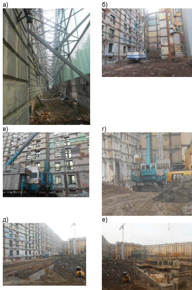
Рисунок 1. Фото участка вдавливания свай (выполнено автором статьи): а – стена фасада, закрепленная на стальных рамах; б – буровая установка для устройстве скважин при погружении в них свай; в, г – установка вдавливания, оснащенная краном; д – стены в грунте с отсыпкой по её периметру грунтовой бермой; е – участок устройства подземных конструкций здания в котловане
