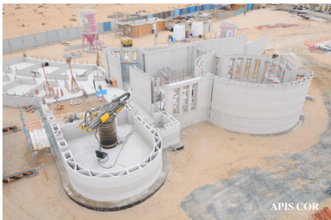
Рисунок 6. Строительство здания в Дубае при помощи 3D-печати. Источник: https://archi.ru/news/85248/-v-dubae-poyavilos-samoe-bolshoe-v-mire-zdanie-napechatannoe-s-pomoschyu-d-printera
