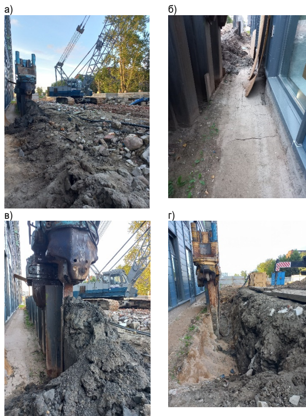
Рис. 5. Этапы статического извлечения шпунта (фото автора): а – УВШ, установленная на извлекаемом шпунте; б – трещины в бетонной отмостке, образовавшиеся в процессе работ; в – грунт, извлекаемый на поверхность вместе со шпунтом; г – траншея, выполненная в примыкании к шпунтовой стенке для снижения сопротивления грунта
